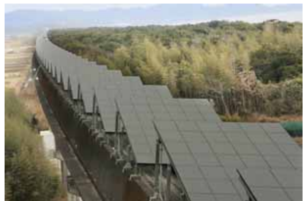
写真 都農第1発電所での実証を経て、施工性・効率性を追及し「都農第2発電所」を建設
