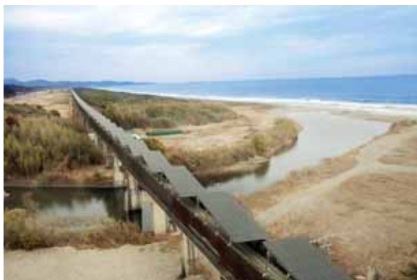
写真 宮崎・日向灘海岸沿いを南北に貫くりニアモーターカー宮崎実験線高架上に建設
