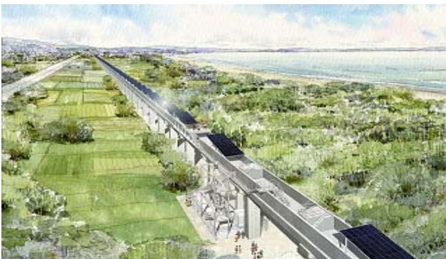
リニアモーターカー宮崎実験線高架上に建設される 都農第2発電所の完成予想図
