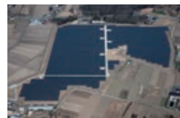
壬生ソーラーウェイ(2017年3月竣工 約16.8MW)
