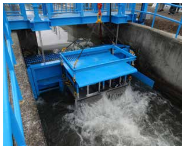
宮城県大崎市に設置した小水力発電機（JAG シーベル）
