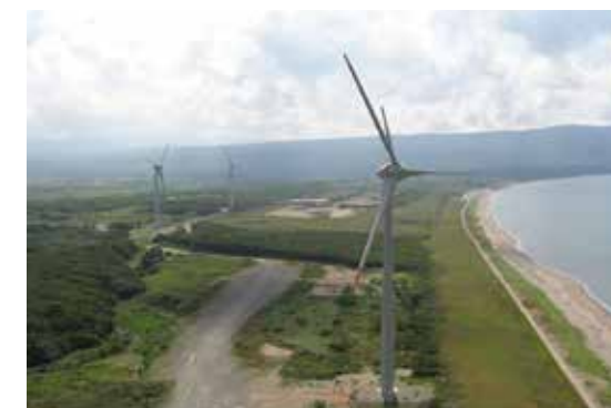
風太風力発電所（東洋設計）
