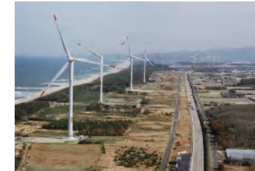
北条砂丘風力発電所 (鳥取県北栄町)
