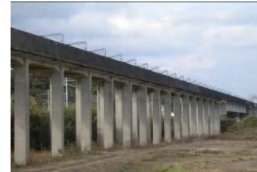
都農太陽光第二発電所 (宮崎県都農町)
