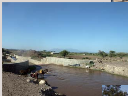
無電化村/学校への電力供給(エチオピア)
