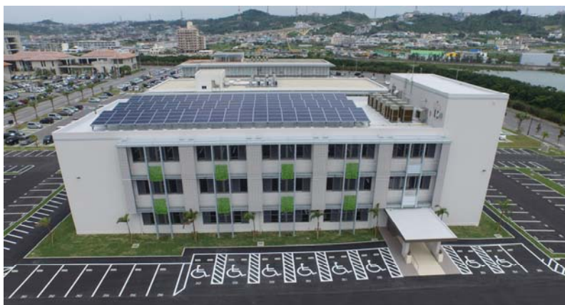
竣工したオフィスビル
